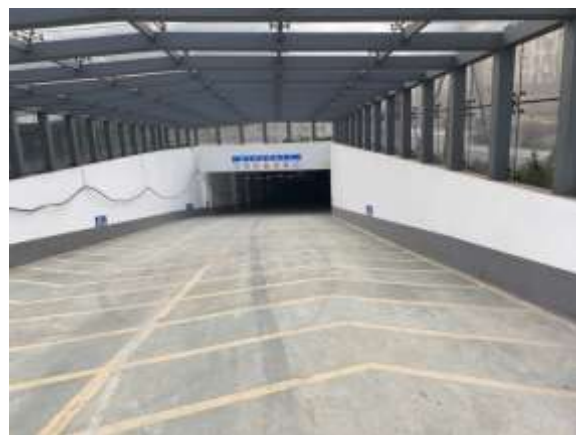
地下车库入口
